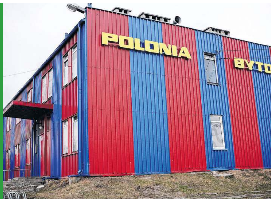
Stłynny „krzywy domek” na stadionie przy ul. Olimpijskiej. Tam mieściły się pomieszczenia klubowe, również szatnie piłkarzy. Budynek został zburzony, stadion jest rozgrzebany i nie wiadomo co z nim dalej. Zdjęcie z 2013 roku.
