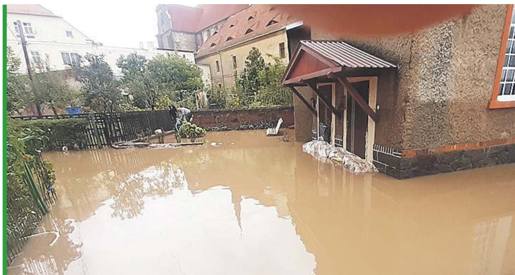
Obejście w centrum Kamieńca Żąbkowickiego. Woda już przeszła. Na ścianie domu widać, dokąd podeszła woda. W tle potężny cysterski kościół Wniebowzięcia NMP. Tam woda nie dotarła.
